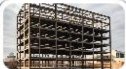
اجرای اسکلت فلزی
