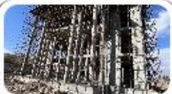
اجرای اسکلت بتنی
